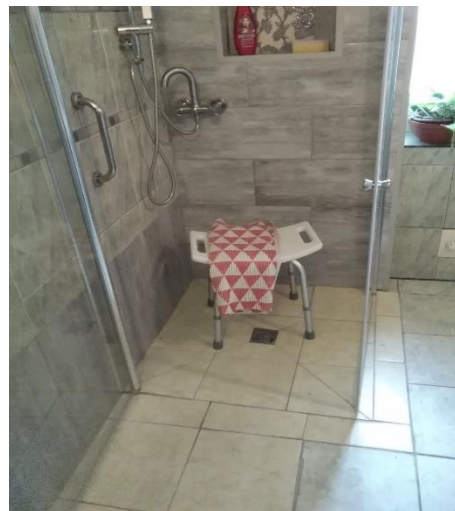
Pomieszczenie po likwidacji barier architektonicznych
